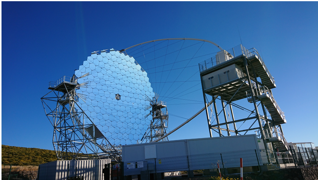
図 2.16 2019 年 11 月現在北サイトラパルマで試験運転を行っている LST 初号機。2018 年 10 月 10 日に建設が完了した。
