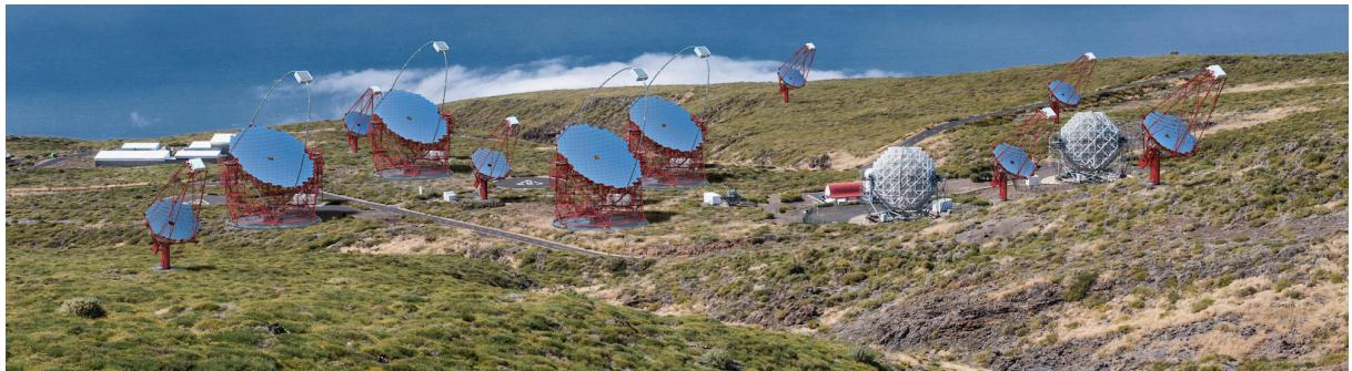
図 2.6 CTA 北半球サイト完成予想図 中央 4 台の望遠鏡が大口径望遠鏡であり、その周辺に存在する 7 台の赤い望遠鏡が中口径望遠鏡である。小口径望遠鏡は、天の川銀河中心の観測等に用いられる予定で南半球のみに設置される。図中右側の白い望遠鏡二台は MAGIC 望遠鏡である。スペイン領ラ・パルマ島ロケ・デ・ロス・ムチャーチョス天文台に建設される。
