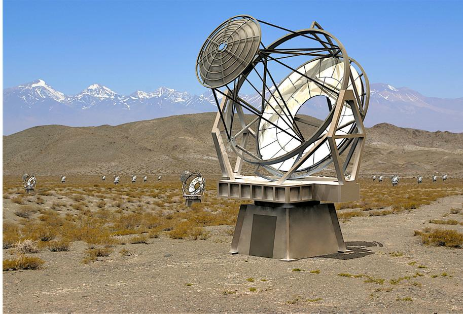
図 2.5: SCT の完成予想図。主鏡と副鏡は複数の非球面分割鏡で構成される。焦点面カメラは副鏡の背後に位置する。
