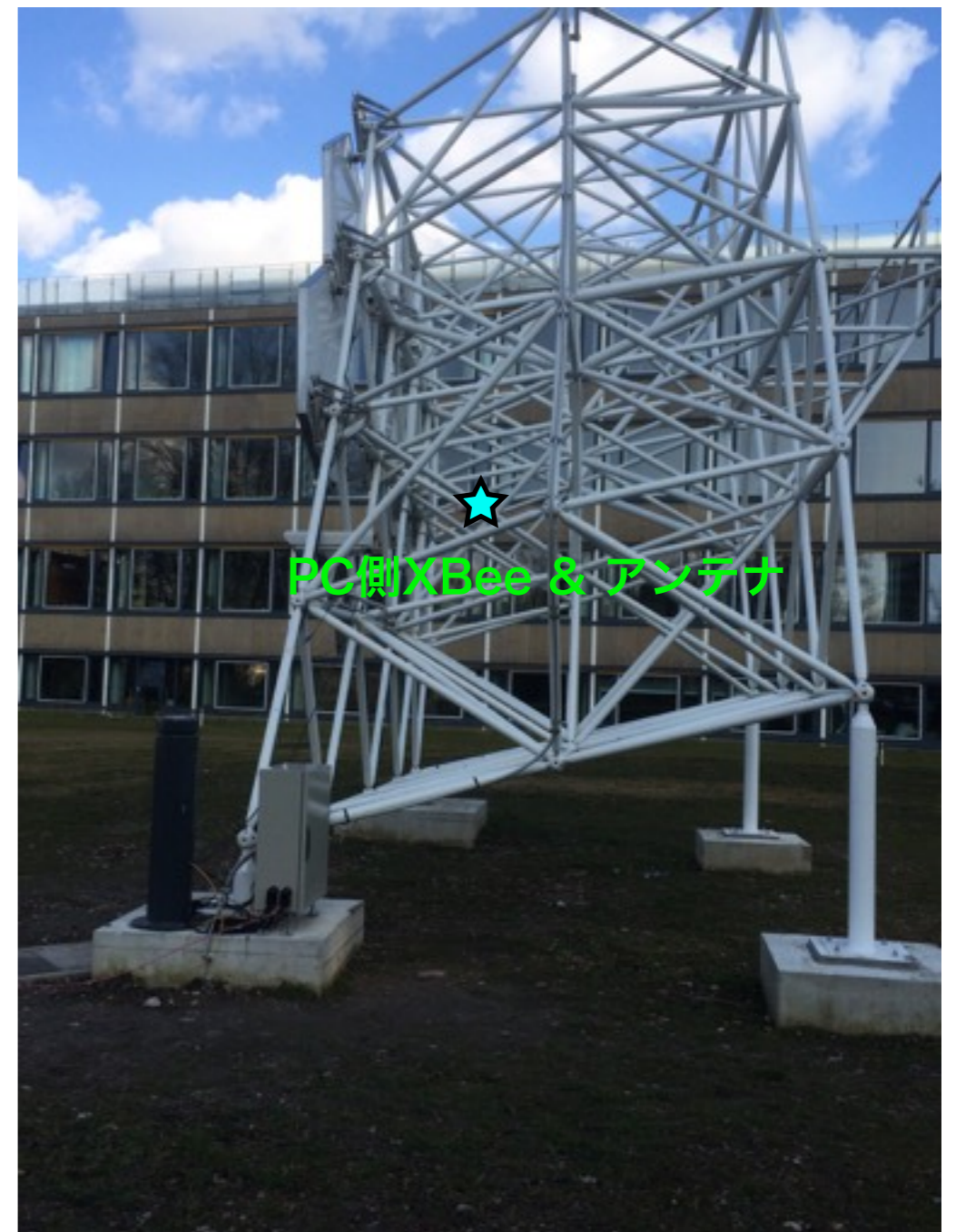
試験構造体（正面右横から）
